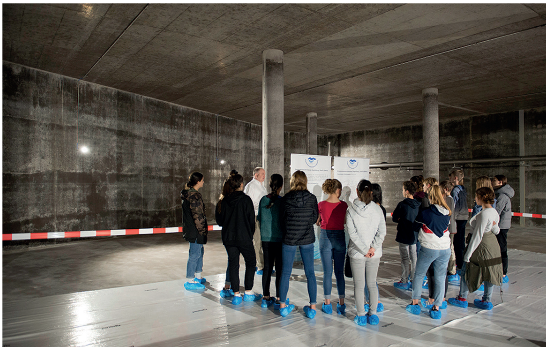
Schülerinnen und Schüler besichtigen im Frühling 2019 die neu erstellte Kammer des Reservoirs Freudenberg. Die Kammer fasst 1,025 Millionen Liter Wasser. Aktuell wird das Reservoir Sonnenberg erweitert, die erste Kammer konnte in diesen Tagen in Betrieb genommen werden, sie fasst 1,7 Millionen Liter Wasser.
