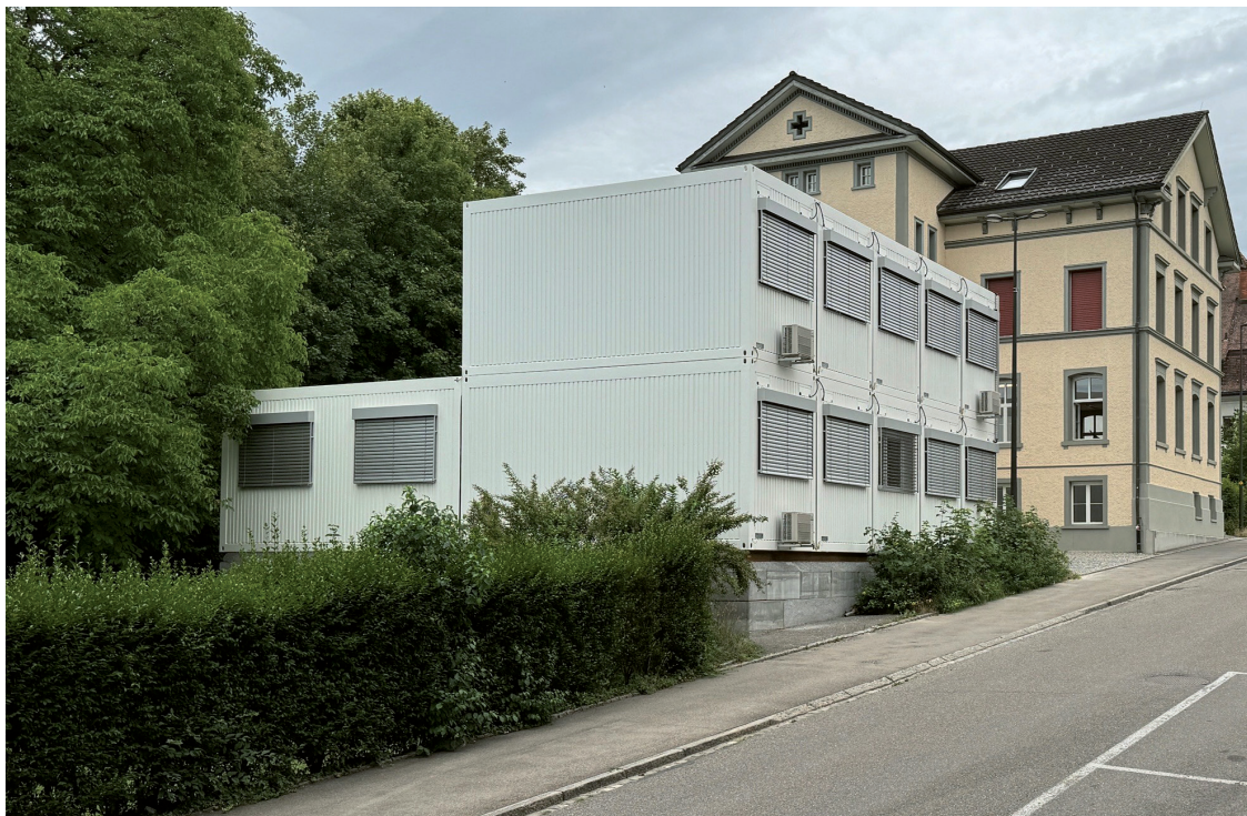
Die neu installierten Container der Schulanlage Kirchstrasse werden im August bezogen. Dahinter die beiden stattlichen Schulhäuser aus den Jahren 1873 und 1909.
