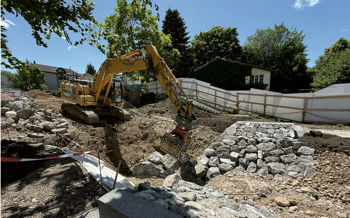
Die Arbeiten am künftigen Bachbett im Abschnitt Uze bis Wiesentalstrasse sind bald abgeschlossen. Im Bild sind die Auflieger für eine künftige Fussgängerbrücke zu sehen. Tetris mit dem Bagger: Stein für Stein gelangt an seinen Platz.
