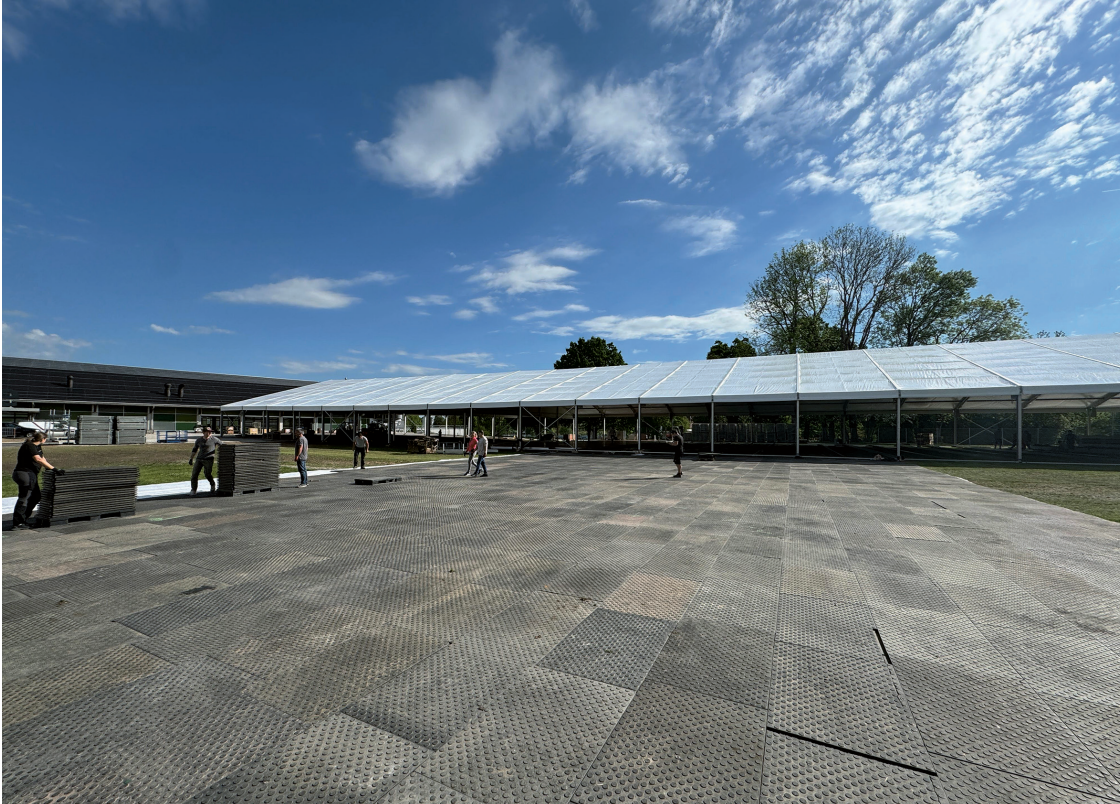
Rückblick auf den Aufbau. Samstagmorgen, 9. Mai, 7 Uhr, Sportplatz Schii: Über 700m 2 Gummipplatten müssen verlegt werden, das riga26 OK packt mit an.
