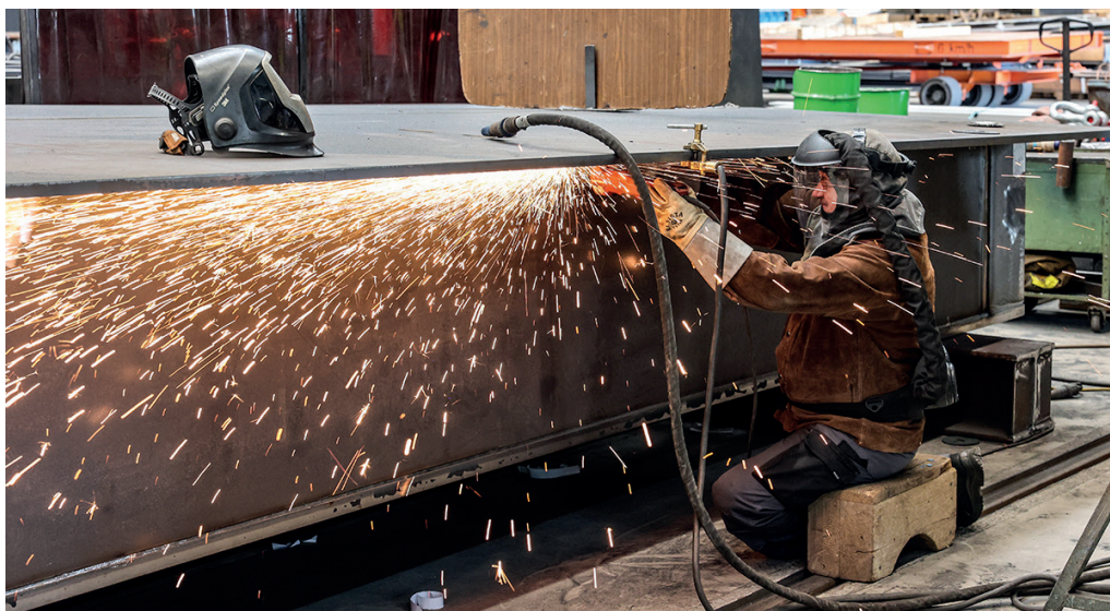
Im Werk wird intensiv an den Stahlelementen der Brücke gearbeitet. Bis Ende Monat sind diese Arbeiten abgeschlossen.
