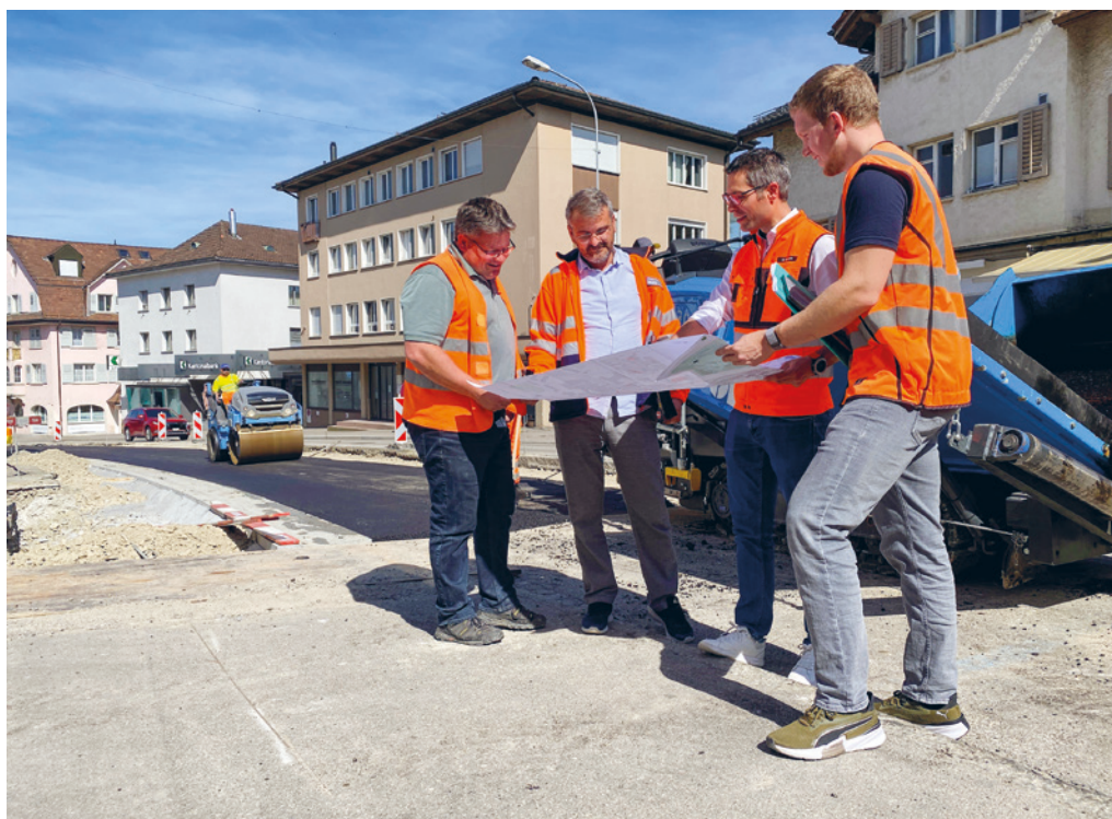
Dialog auf der Baustelle. Von links: Michael Aemisegger, Bauführer der Toldo AG, Besim Osmani, Projektleiter Tiefbau der Gemeinde, Balz Ruprecht, Leiter Strassenbau des kantonalen Tiefbauamtes und Reto Käch, Bauleiter der RKL Emch + Berger Ingenieurbüro AG, besprechen die Details der nächsten Etappe, während im Hintergrund der frisch eingebaute Belag gewalzt wird.
