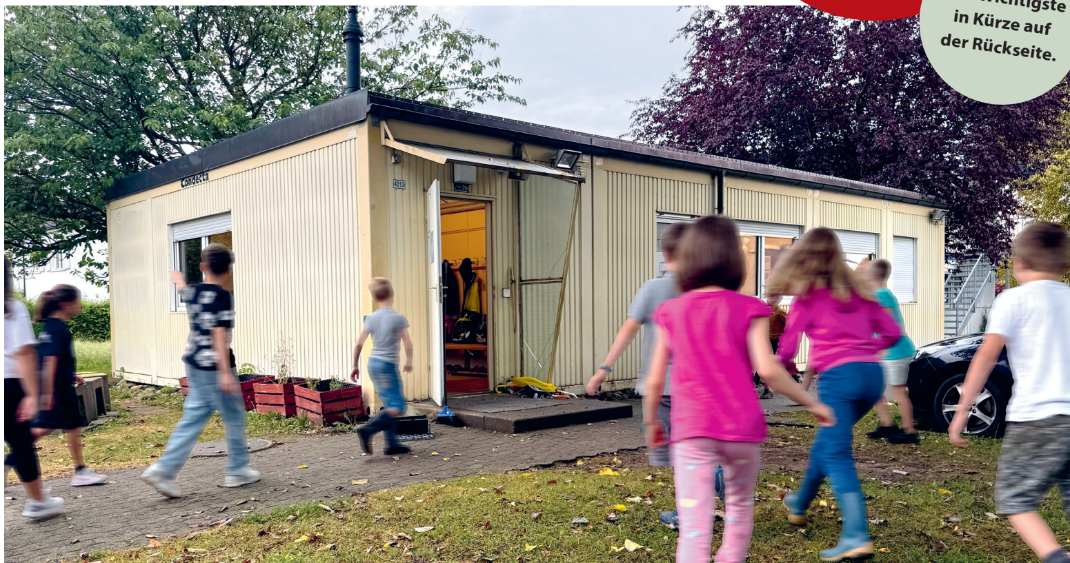
Dieser Container im Neuhoof war als vorübergehende Lösung gedacht. Er steht schon seit 30 Jahren und ist nur einer von vielen Containern in Uzwiler Schulanlagen.
