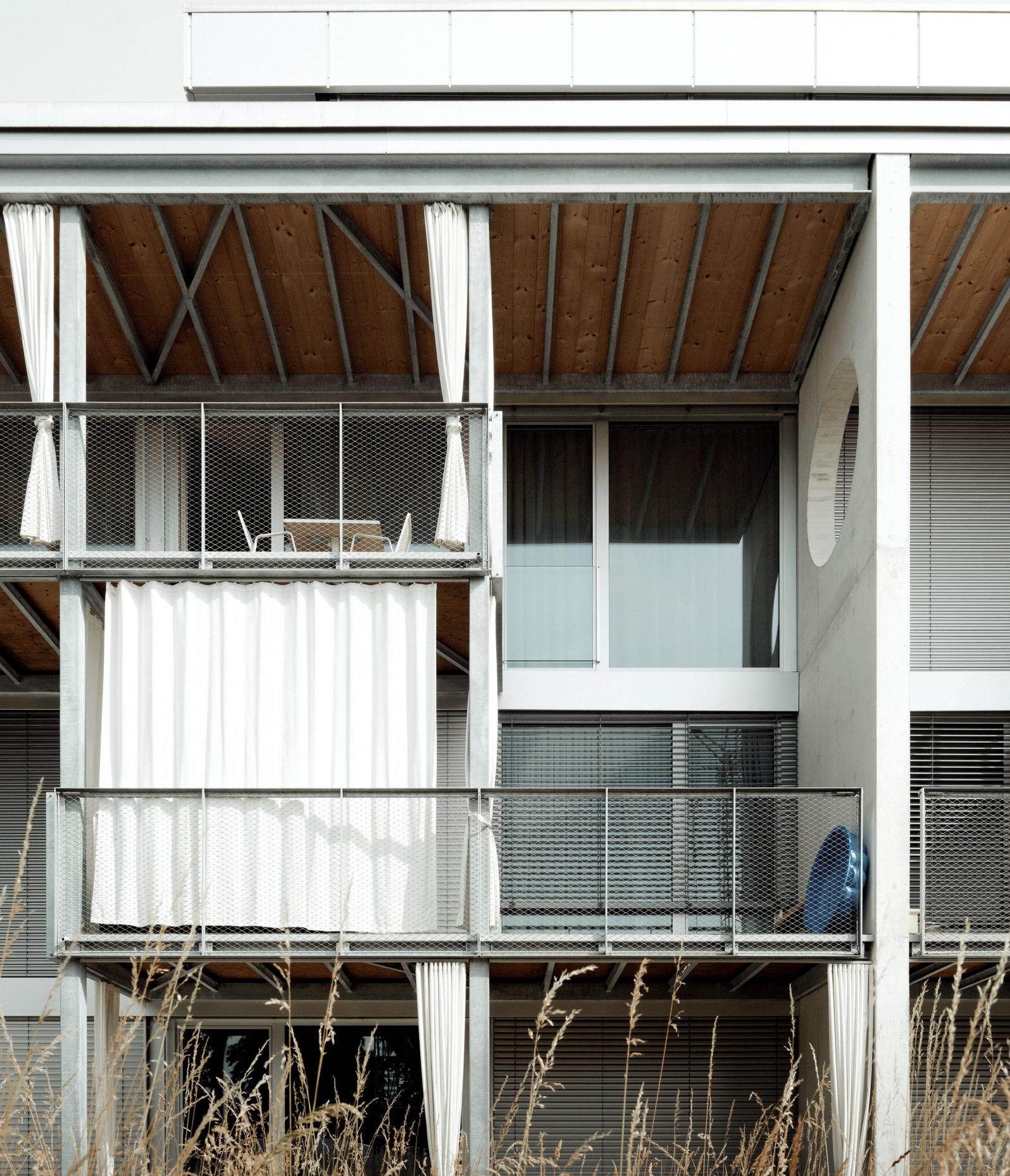
Bildhaft wurde die Geschichte des Ortes in den Neubau übersetzt: In den Obergeschossen des Vorgängers lagerten Rohre mit einem Durchmesser von 50 cm. Stark vergrössert, prägen sie nun die Südsicht in Form der runden Durchstösse. Mit den hohen Betonwänden wurde ein weiteres Bild aus dem Inneren des Vorgängerbaus nach aussen gestülpt: Die scheibenartigen Betonwände bilden zusammen mit den gerüstartigen Balkonen eine Reminiszenz an das einstige Regallager.
