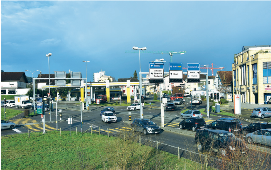
Eingangstor: 19'300 Autos passieren durchschnittlich jeden Tag den Augarten. Spitzentag 2016 war der 27. Mai mit 24'400 Autos. Die Kreuzung wartet auf umfassende Verbesserungen.
